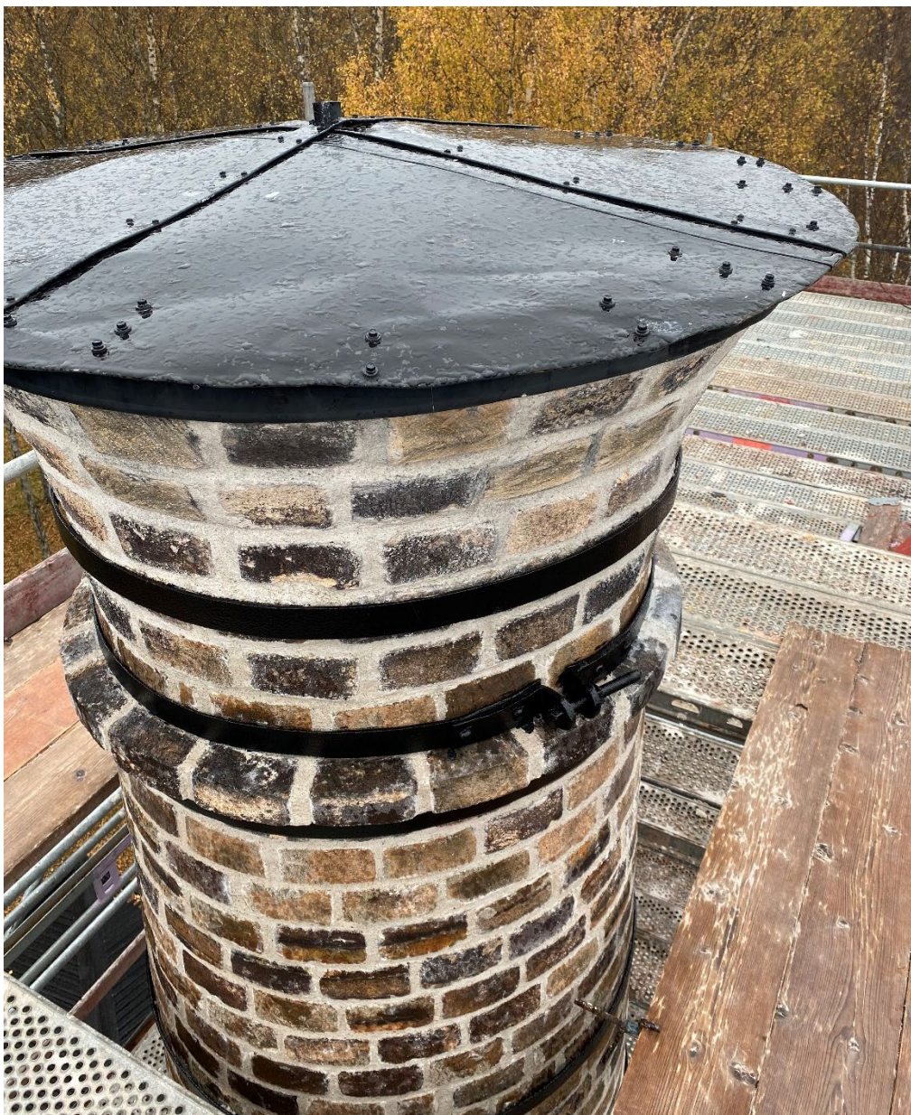
Figur 19. Avtäckningen högst upp på skorstenen har målningsbehandlats. Notera att det utkragade krönet vid avslutade arbeten endast består av gula eldfasta tegelstenar. Foto: 2021-10-19.
