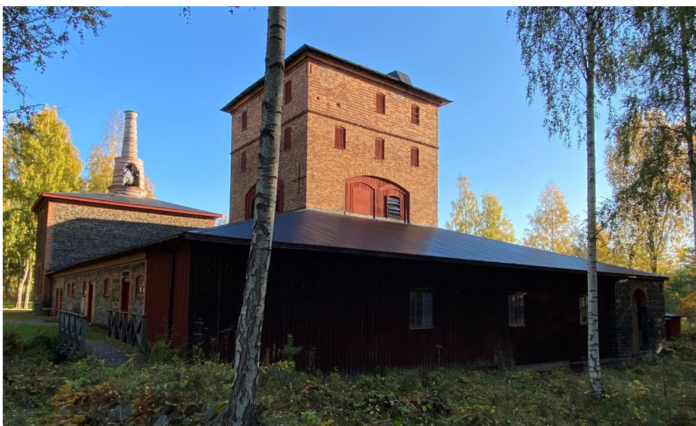
Figur 25. Anläggningen med masugnen sedd från söder efter avslutade arbeten. Arbetet med målning av panel på den södra lågdelen utgick. Foto: 2022-10-04.
