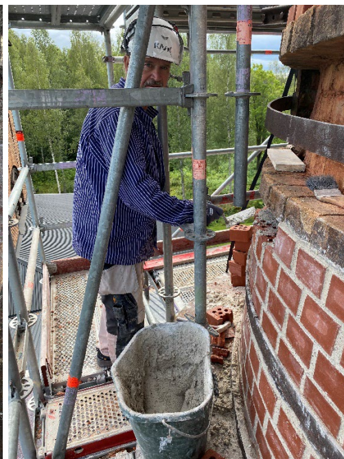
Figur 15. Under pågående arbeten med återställning av skalmuren i den nedre breda skorstensdelen. Murare Anders Persson från Hälsinge Mureri AB utför jobbet. Foto: 2021-08-19.
