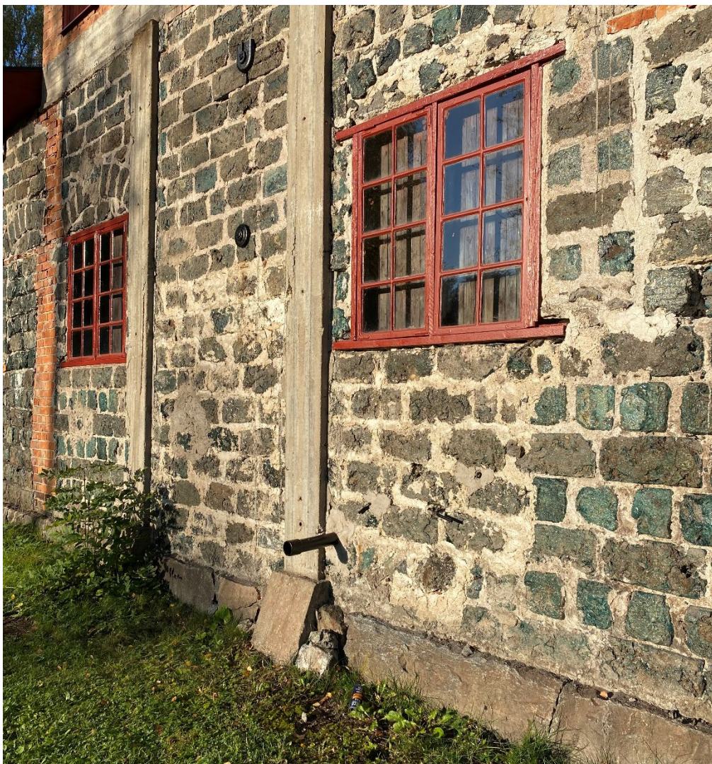
Figur 20. Renoverade fönsterbågar och karmar på den östra fasaden. Foto: 2022-10-04.
