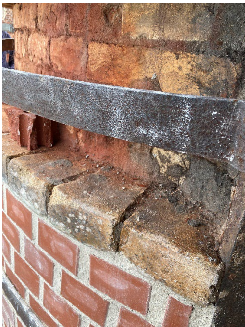
Figur 14. Under pågående arbeten med återställning av skalmuren i den nedre breda skorstensdelen. Notera det gula bandet av eldfast tegel, där endast enstaka tegelstenar behövde bytas ut. Foto: 2021-08-19.
