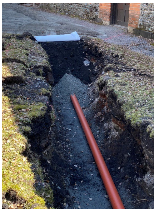
Figur 13. Under pågående arbeten med avledning av vatten från markanslutet stuprör på den västra fasaden. Foto: 2021-04-30.
