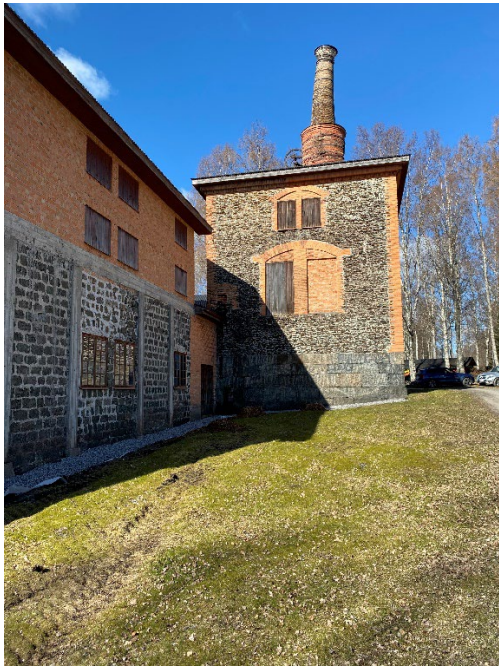
Figur 4. Rostugnsdelen med skorsten sedd från öster. Dräneringen utefter dessa båda fasader var i stort sett färdigställd vid besöket. Foto: 2021-04-30.
