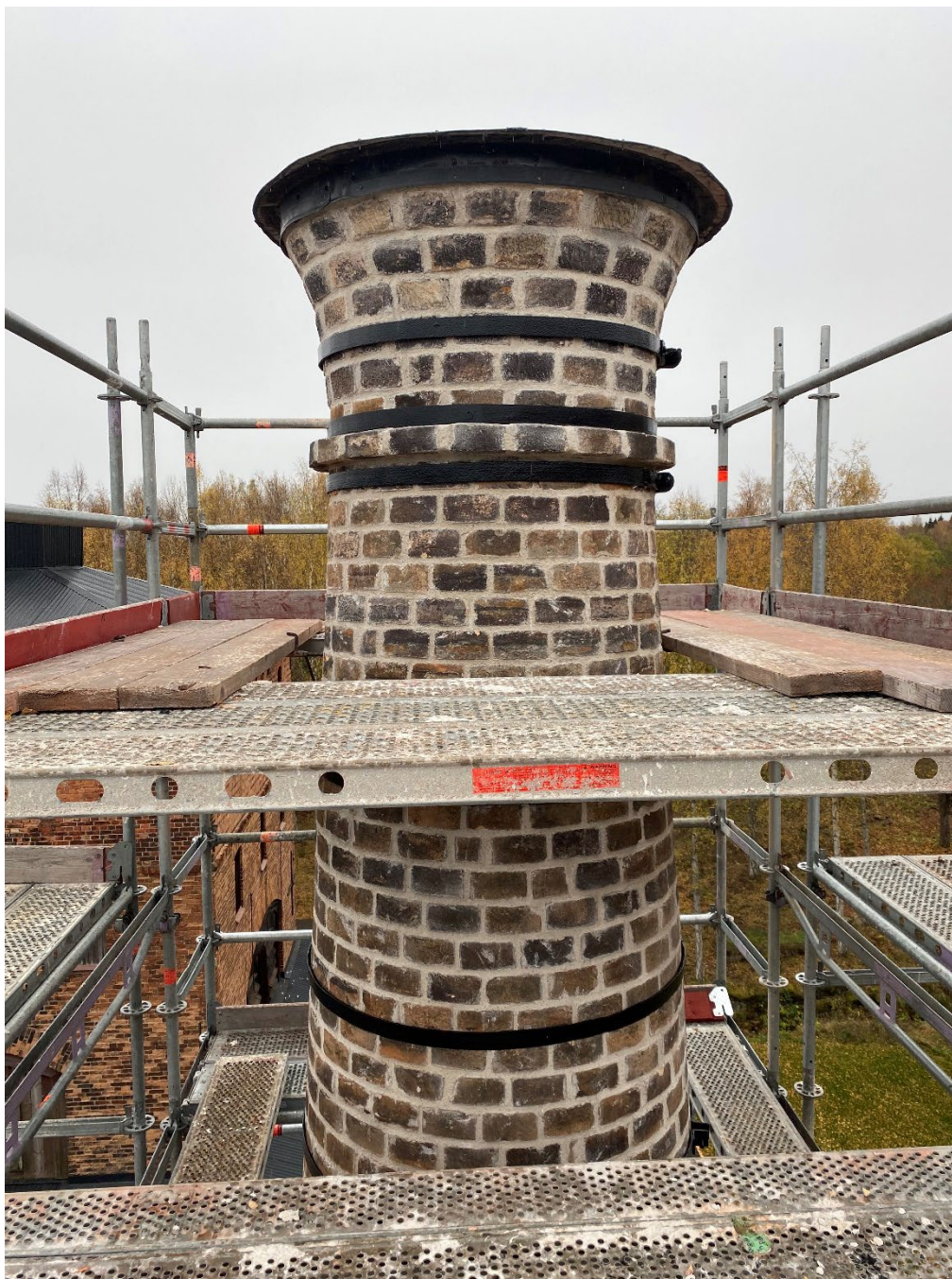
Figur 18. Den övre skorstensdelen är återställd och alla järndetaljer är målningsbehandlade. Foto: 2021-10-19.
