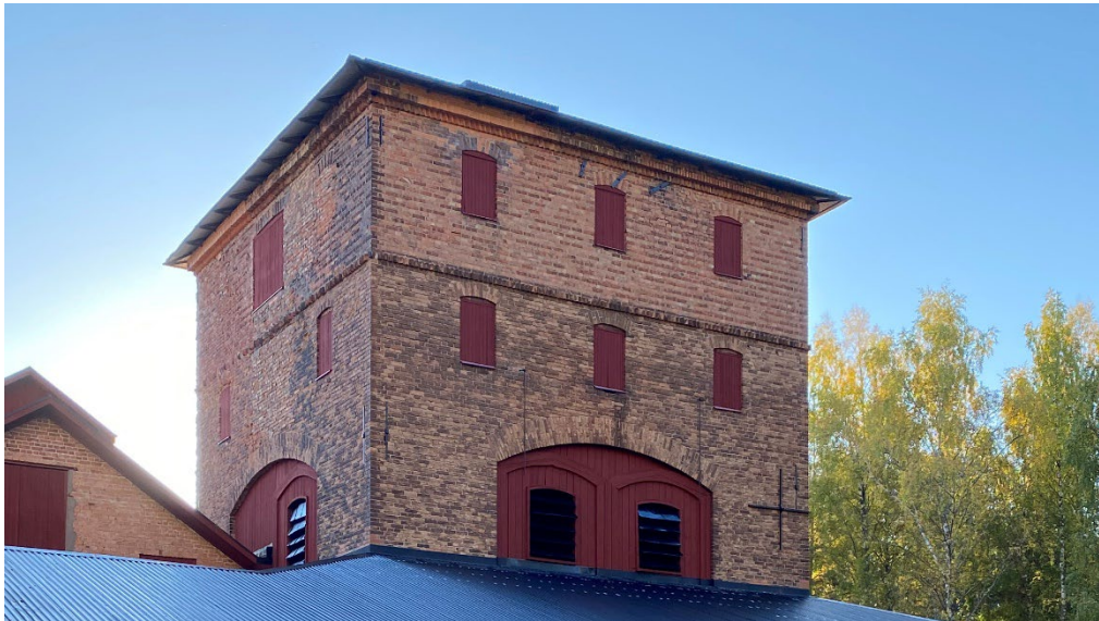
Figur 26. Masugnen sedd från nordväst. Notera målningsbehandlad jalusi i de stora muröppningarna samt ankarsluten i fasaden. Foto: 2022-10-04.
