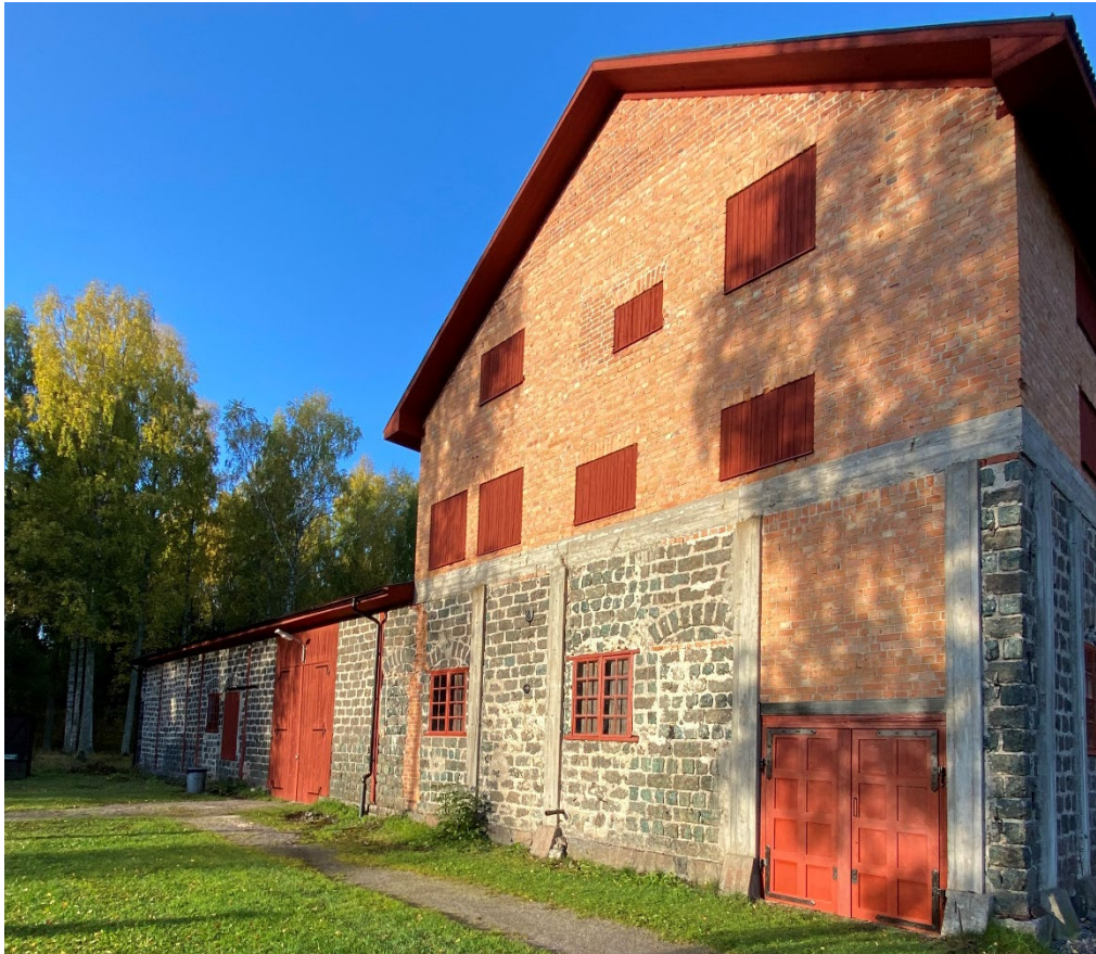
Figur 22. Luckor, portar, fönster och takfot på den östra sidan, efter avslutade arbeten. Foto: 2022-10-04.
