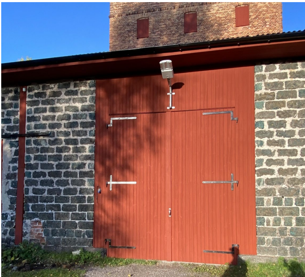
Figur 28. Den höga porten mot öster har målningsbehandlats. Det samma har skett med gångjärn och beslagning. Foto: 2022-10-04.
