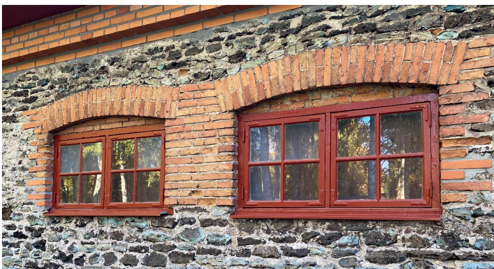
Figur 21. Renoverade fönsterbågar och karmar på den västra fasaden. Foto: 2022-10-04.
