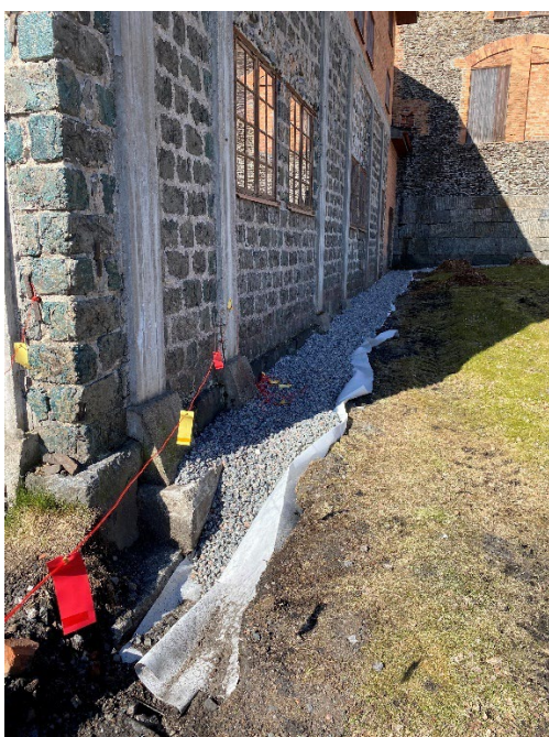
Figur 12. Dränering efter tjärfabrikens norra fasad under pågående arbeten. Foto: 2021-04-30.
