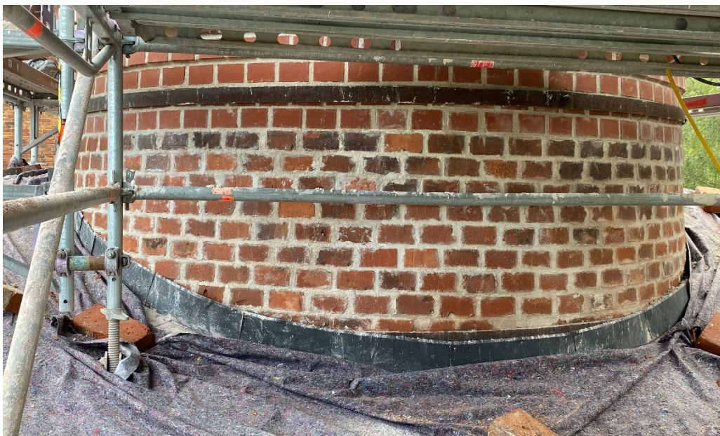
Figur 16. Den nedre breda skorstensdelen, precis vid anslutningen till taket på rostugnen. Notera mötet mellan omfogad skalmur längst ner och nymurad skalmur med nya skorstenstegel lite högre upp. Foto: 2021-08-19.
