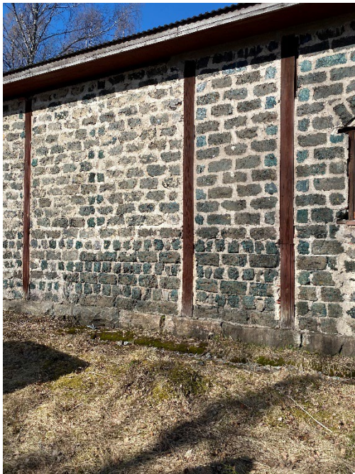
Figur 8. Stolpar av trä på den östra fasaden. Foto: 2021-04-30.
