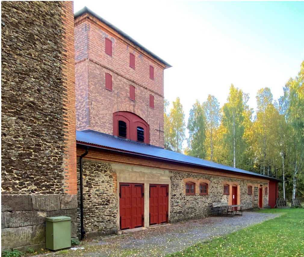
Figur 24. Den västra sidan efter avslutade arbeten. Notera jalsierna av järnplåt längst ner på masugnen samt de nytillverkade dubbelportarna närmast i bild. Foto: 2022-10-04.
